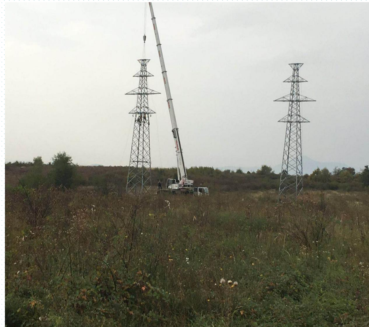
塞尔维亚110KV送电线路项目
