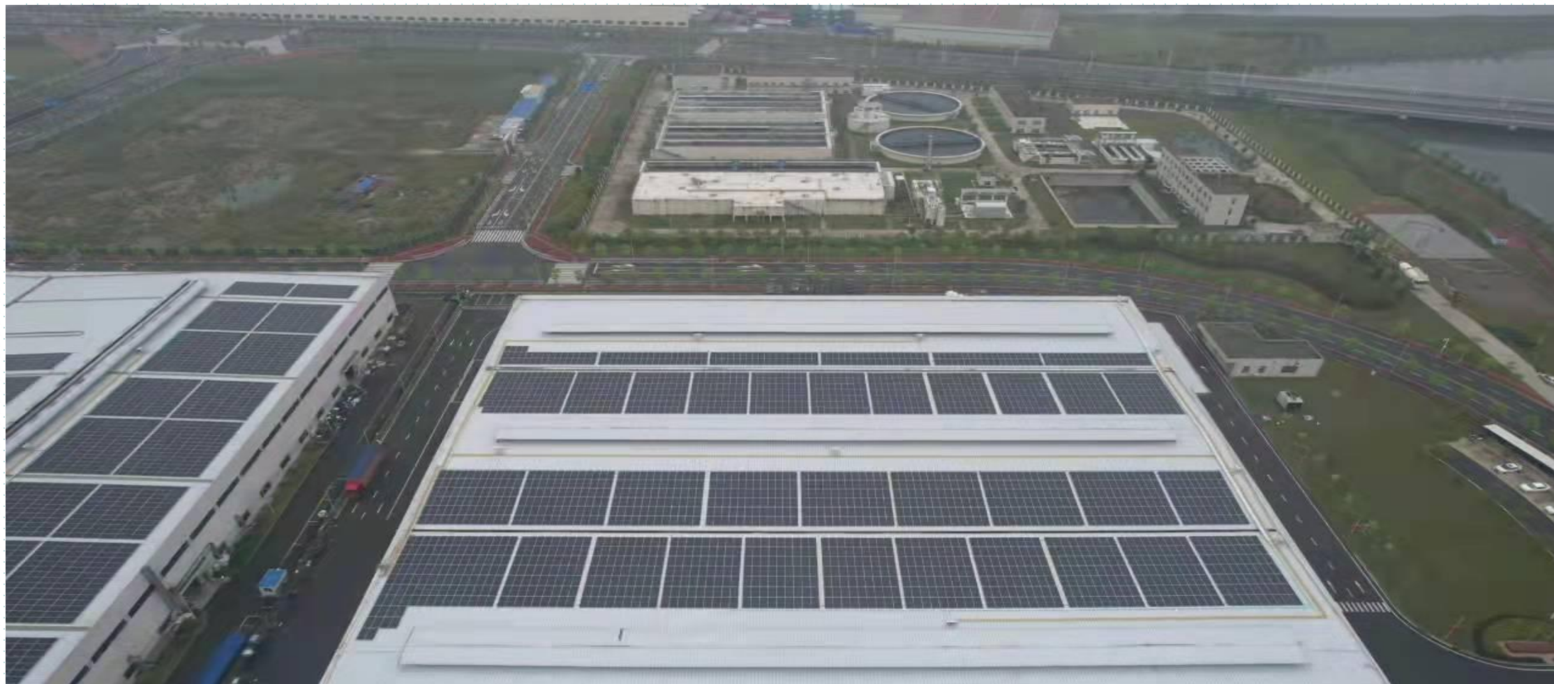
鑫桥400KW屋顶分布式项目
